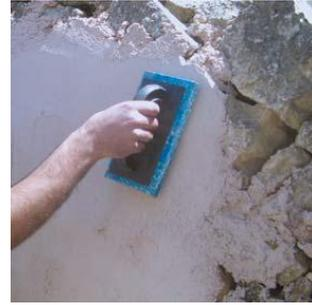
شكل(1-13): خطوات عمل القصاره التقليدية. (بشارة، 2004م)
