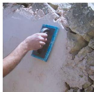
شكل (13-1) : خطوات عمل القصارة التقليدية . (بشاره، 2004م)
